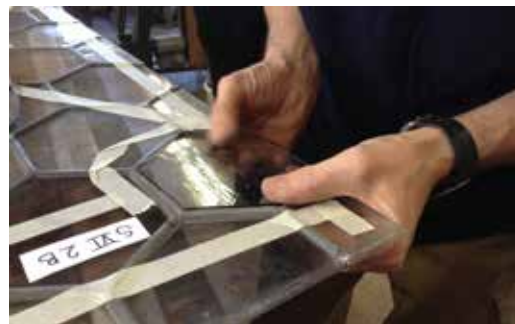
Eine Wabenscheibe wird ersetzt, ohne Klebeband würde das Fenster auseinanderfallen.
